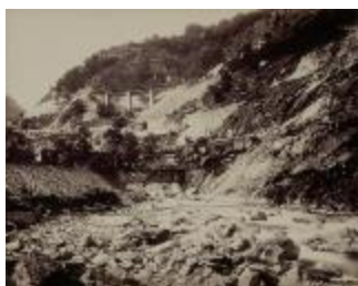
Tronçon ferroviaire dans la vallée de la Biaschina, 1888, A.C. Champagne. Tirage numérique.
